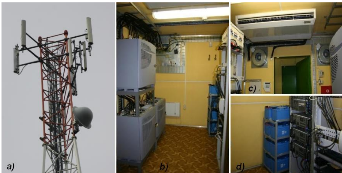
22 pav. a) Antenos GSM bokšte, b) trys bazinių stočių vidiniai moduliai, c) kondicionavimo įranga, d) nepertraukiamo maitinimo šaltinis
